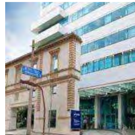
HOSPITAL LEFORTE LIBERDADE
