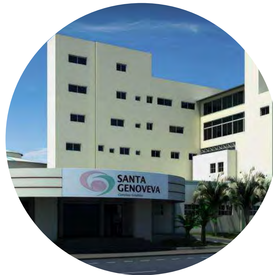
HOSPITAL SANTA GENOVEVA
